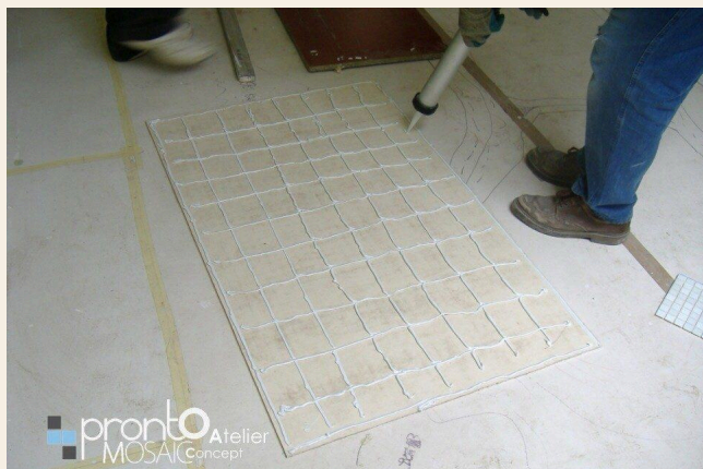
Un pavimento composto da elementi preparati.
