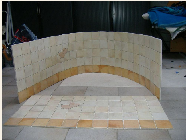
Gebogen bekleding in een demonstratieopstelling.
